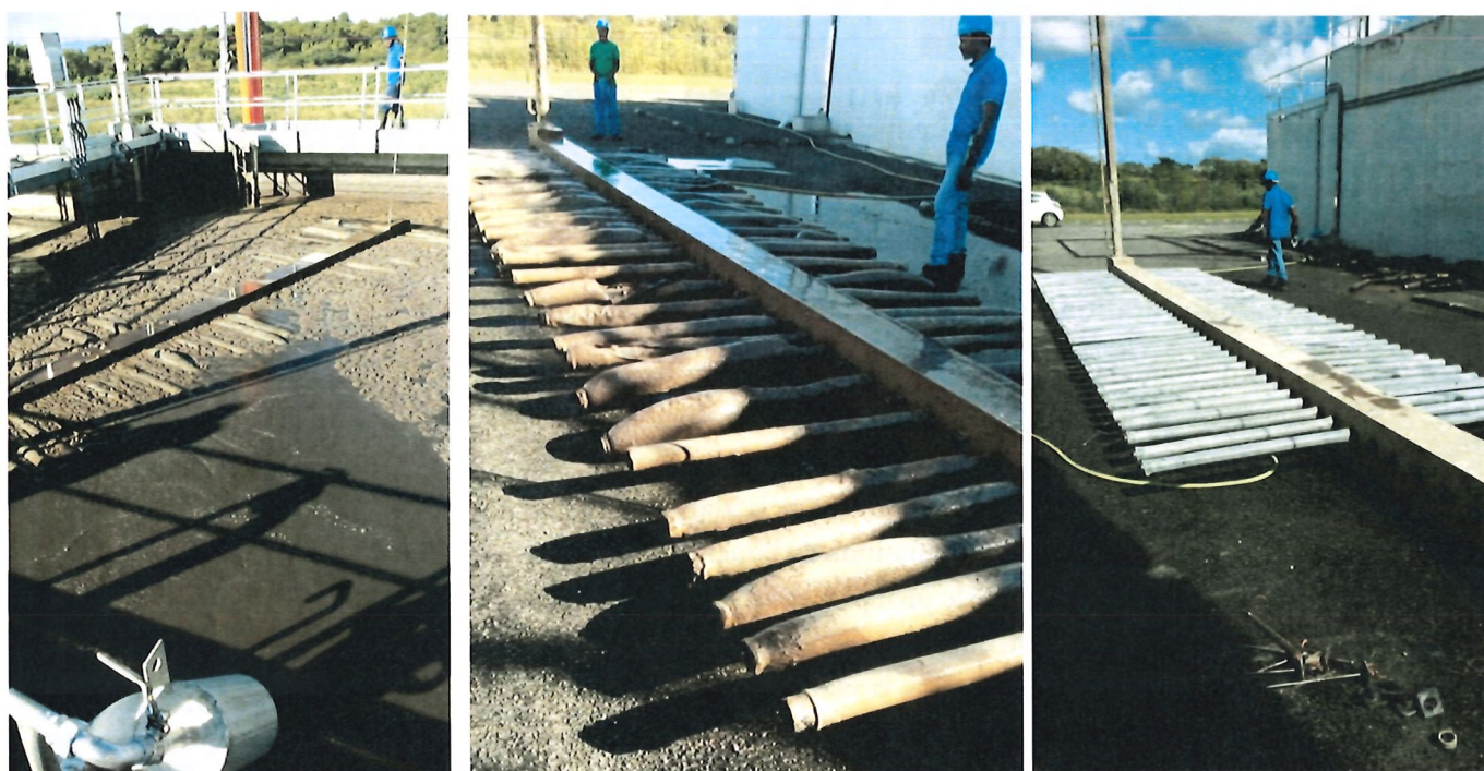
Figure 29: Opération changement des diffuseurs STEU Lalanne
