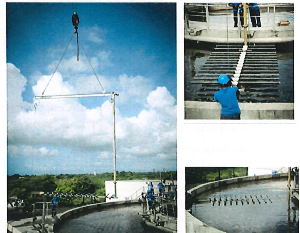
Figure 26: Remplacement des diffuseurs STEU Guenette
