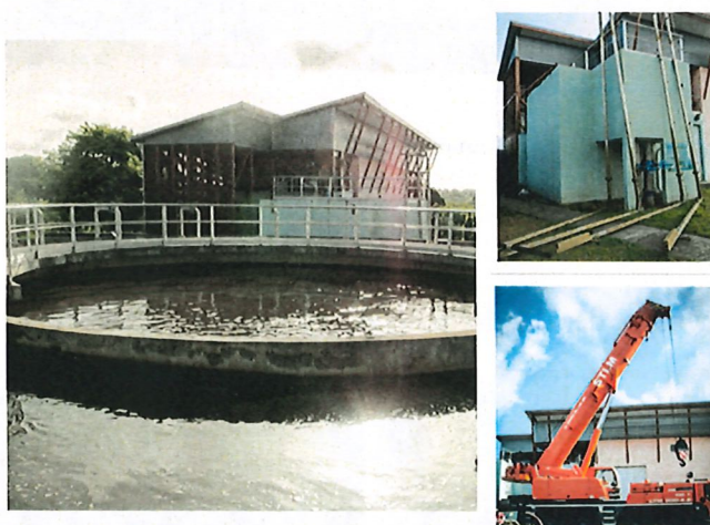
Figure 27: Préparation remplacement des diffuseurs
